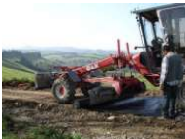
Pose du géotextile
