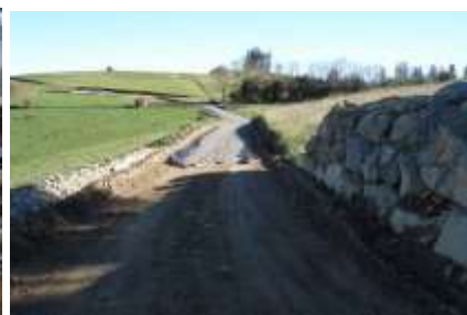
Mise en place du gravier
